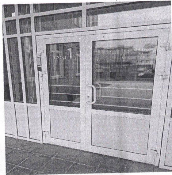
фото № 6 «Дверь (на центральном входе)»
