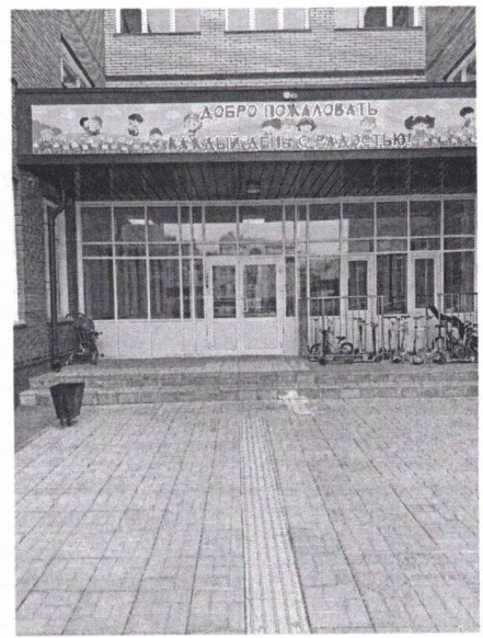
фото №2 «Путь (пути) территория прилегающая к зданию»
