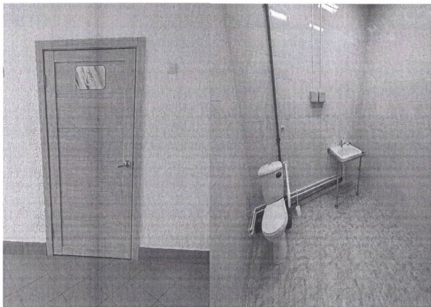
фото № 17 «Туалетная комната»
