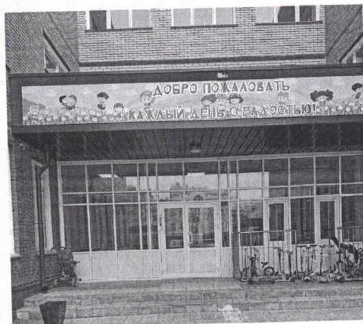
фото № 3 «Лестница (наружная)»
